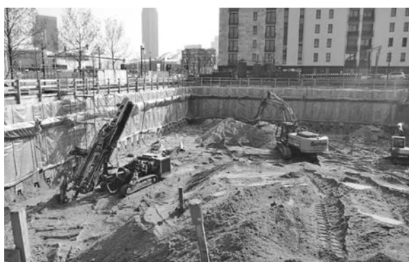
写真—27 基礎工事の作業状況
