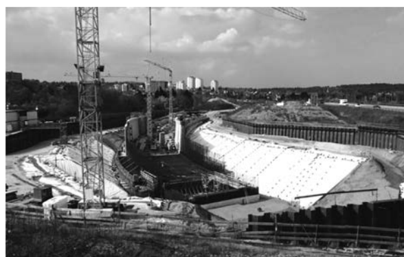
写真—28 A66-A661 Riederwald Tunnel の施工状況
