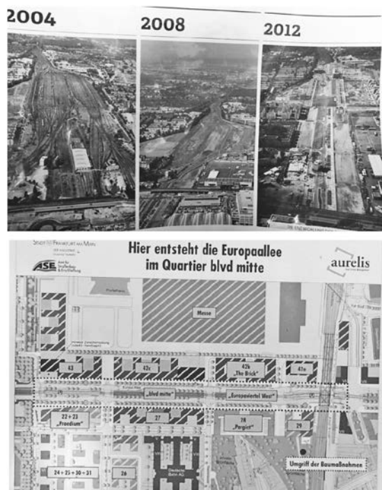
写真—26 工事の経過状況と開発計画
