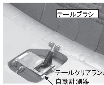
写真-1 計測器の設置状況（実績工事の例）
