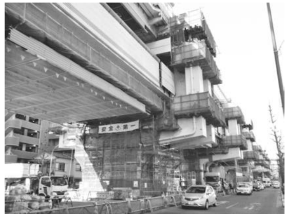
写真-5 本工法による橋脚の設置状況
