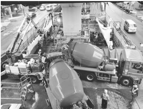
写真二 コンクリート打設状況
