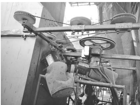
写真一七 乾式ワイヤーソーによる上層柱の切断
