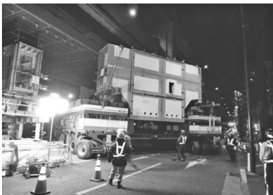
写真-4 新設橋脚の下層柱の架設状況
