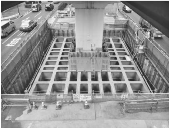
写真一 鋼製格子部材の設置状況
