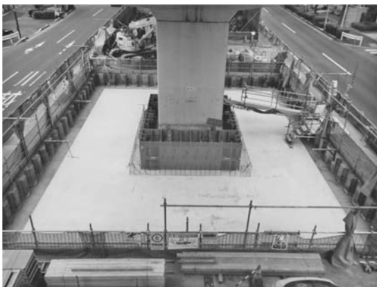
写真三 合成構造フーチングの構築完了
