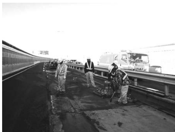
写真—2 ガスバーナを使用した路面乾燥作業
