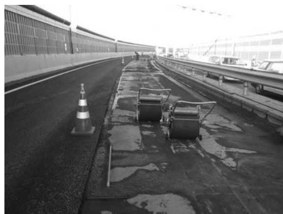
写真—1 スポンジローラを使用した吸水作業
