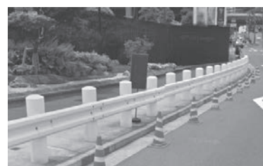
l. 車両衝突対応型ボラード (ガードレールビームを付けた例)
