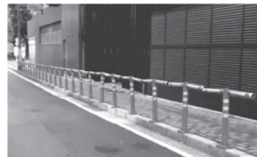
c. ソフトボラード (T型タイプとして柵の機能を付加)
