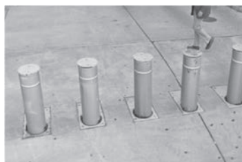
k. 車両衝突対応型ボラード (ライジングタイプ)
