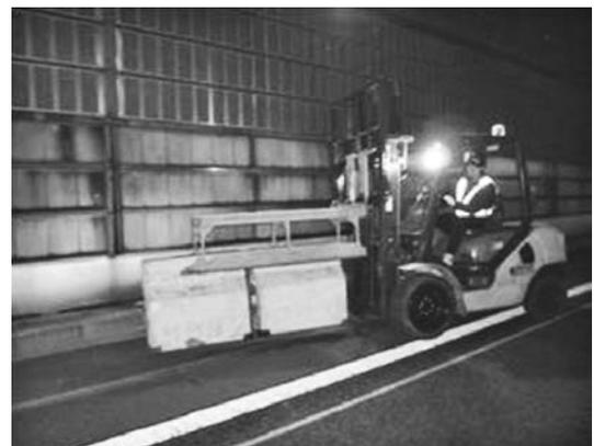
写真一七 防護ブロック設置状況
