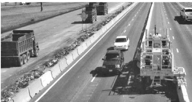
写真—3 工事車線規制運用用
