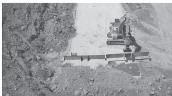
写真—1 鋼製型枠設置状況
