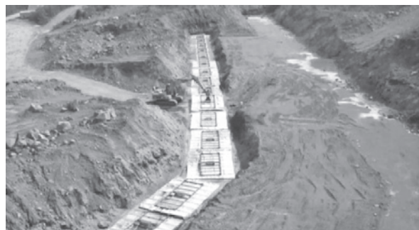
写真—2 養生マット設置状況
