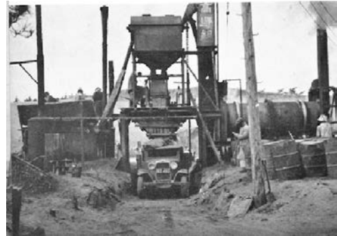
写真 2-15 高野式プラント 福岡県国道 2 号線工事 箱崎～馬出間 箱崎宮前海岸砂浜に設置（株高野組）
