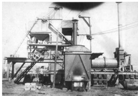
写真 2-8 横浜林町 (大成建設(株)道路部 現：大成ロテック(株))
