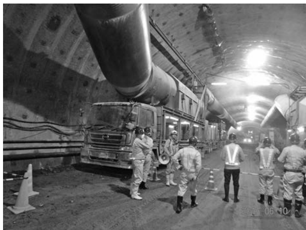
写真—5 吹付作業見学
