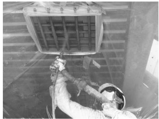
写真一 鉄筋背面への充填性試験状況
