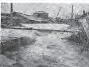
写真(上)間の島堤防決壊・樺木町通 (下)廣澤町松原渡附近
