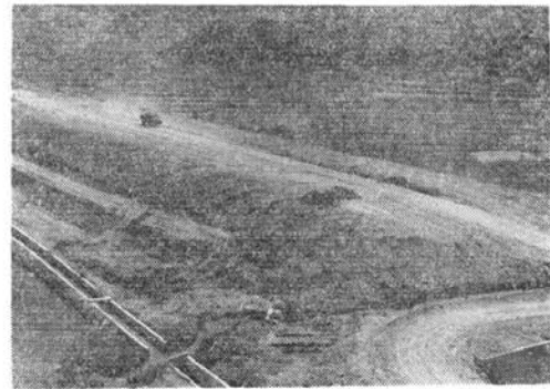
写真-1 盛土部の敷均し転圧
