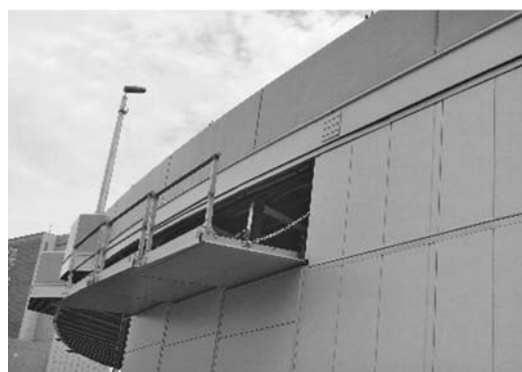
写真—4 開閉式側面パネル
