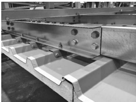
写真—5 裏面パネルの支持構造
