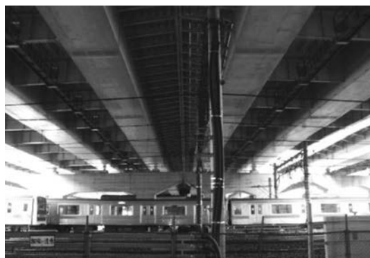
写真—1 鉄道上の鋼桁橋
