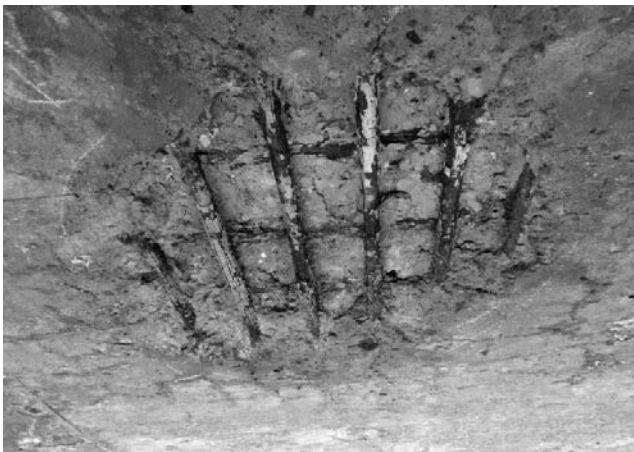
写真二 コンクリート床版の損傷
