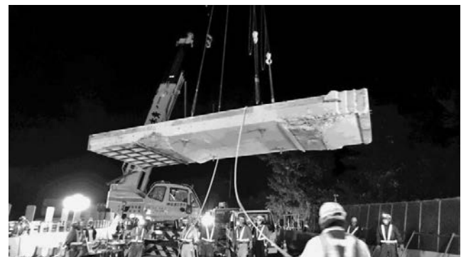
写真三 工事状況（既設床版を撤去している様子）
