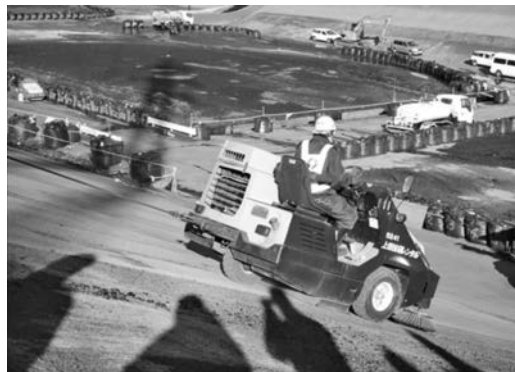
写真-2 定張力ウインチに支持された清掃車による斜面作業
