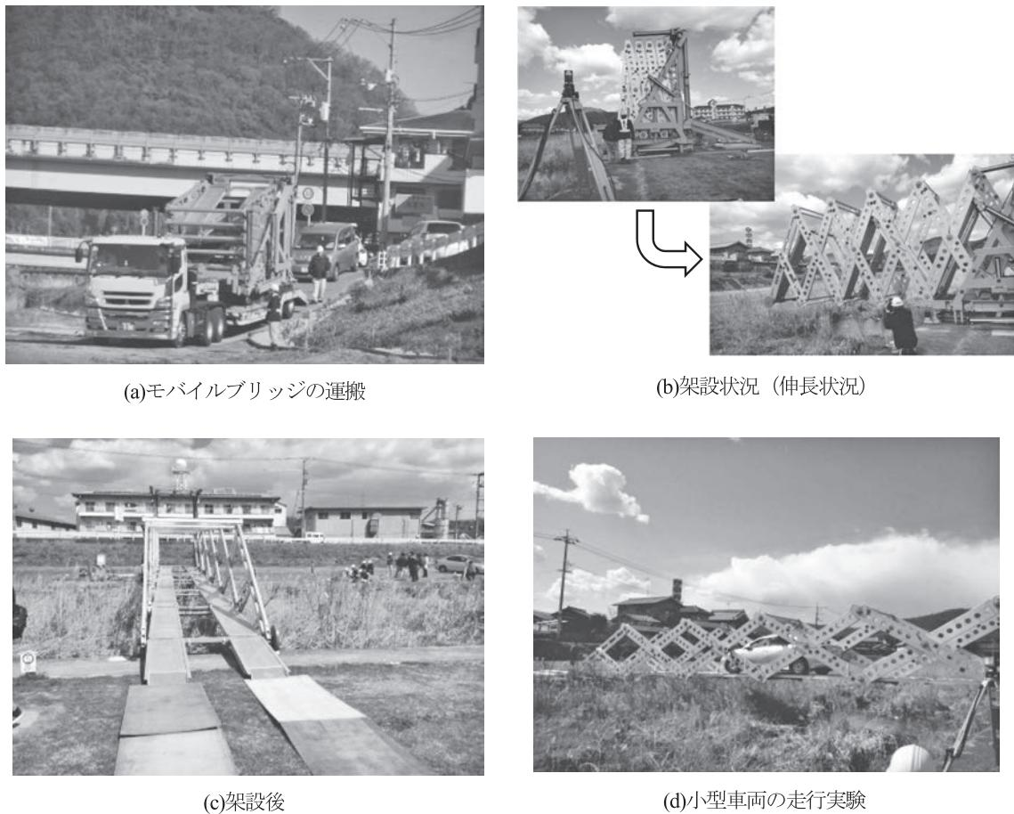
写真一4 実河川での架設実験状況（筆者撮影）
