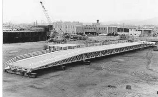
写真一 1 応急組立橋（新潟防災センター）<sup>1)</sup>
