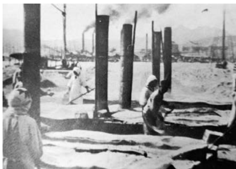
写真 2-20 骨材の鉄板乾燥 徳山町
