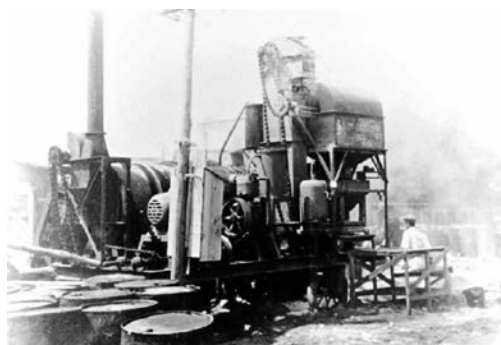
写真 2-36 東京工機製 400 yd 2 プラント 山科に設置 (東亜道路工業(株))
