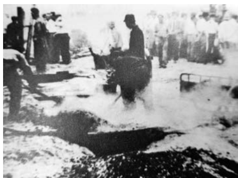
写真 2-21 アスファルト合材の鉄板練り
