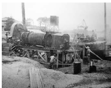
写真 2-35 イロコイス社 (米) 製 800 yd 2 プラント (8 ~ 12 t/H) (世紀建設工業(株))
