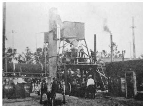
写真 2-19 当時のアスファルトプラント （日本道路舗装工業株 現：日本道路株）
