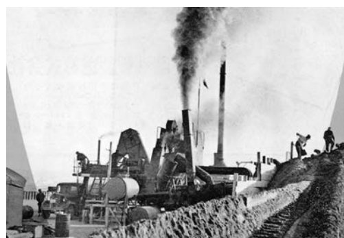
写真 2-37 バーバーグリーン社製 840-B 型 コンティニアス型 40 ton/h 『日本舗道五十年史』 (日本舗道(株))
