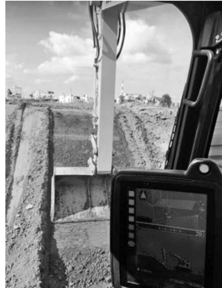
写真—5 インテリジェントマシンコントロールによる法面整形
