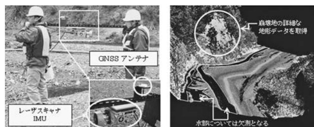
図-13 可搬式による計測事例
