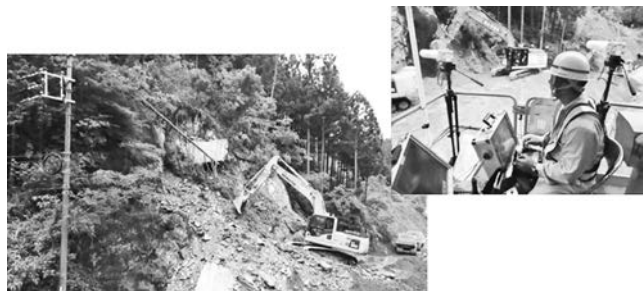
写真—1 災害復旧で活躍する無人化施工機械（玉石重機㈱提供）
