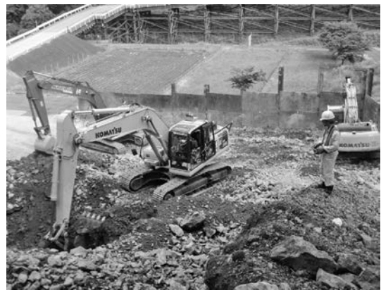
写真一 4 遠隔操縦状況
