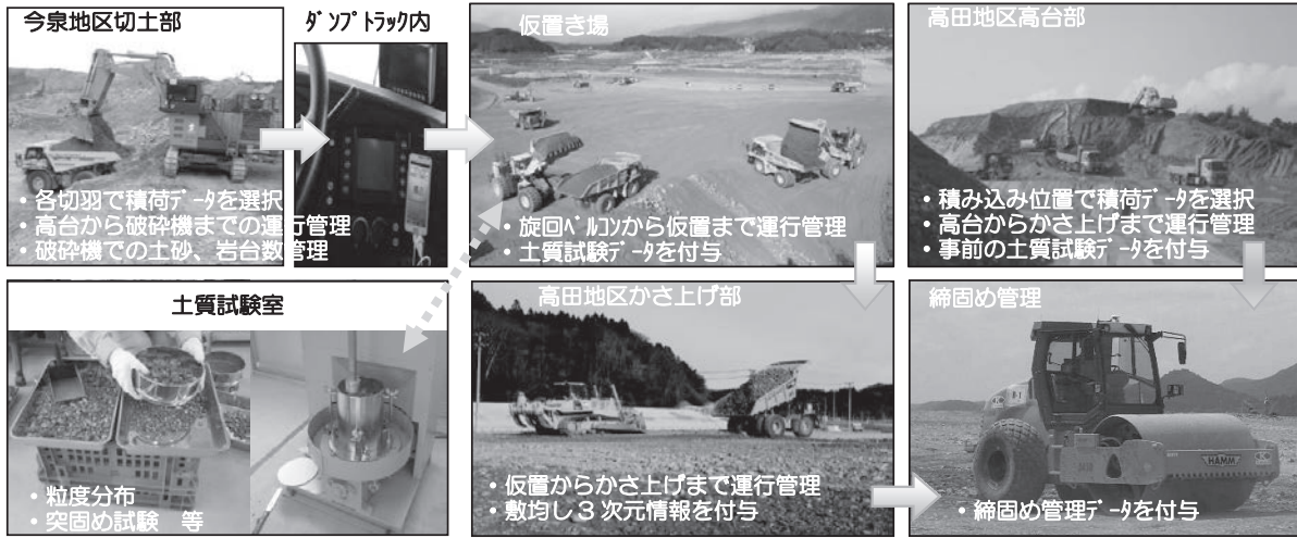
図一六 盛土材料のトレーサビリティ管理
