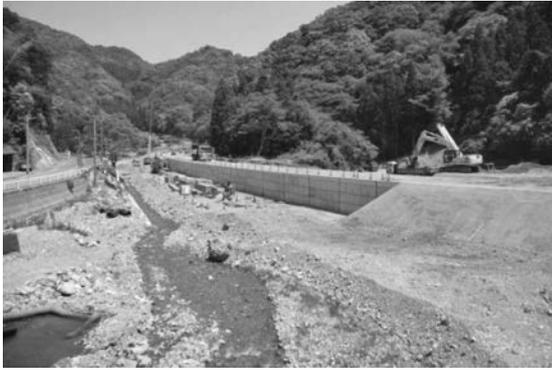
写真—5 「GRS擁壁」の施工状況<sup>4)</sup>
