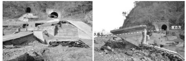
写真一 3 東日本大震災における津波による被災例<sup>3)</sup>
