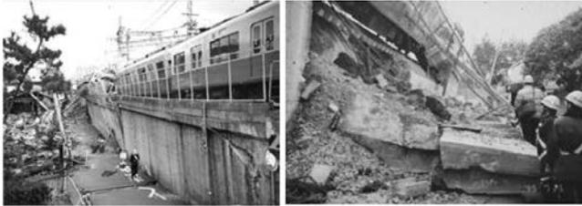
写真一 1 兵庫県南部地震での従来工法の被災例<sup>1)</sup>
