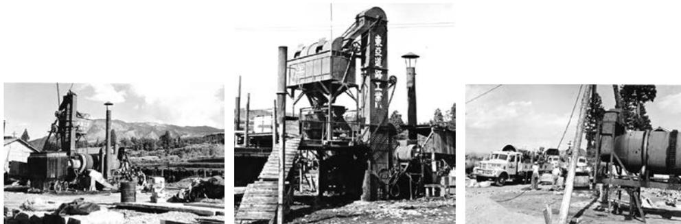
写真3-1 東京工機製 1,500yd<sup>2</sup>アスファルトプラント
