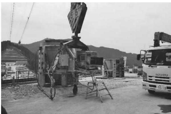
写真一 3 5.0m<sup>3</sup> コンクリートバケツ
