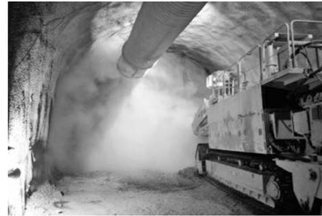
写真一6 RE-2400QDP 機械掘削の切羽の状況
