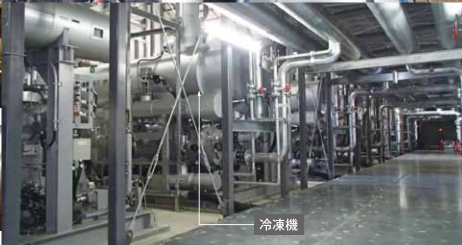
凍土方式による陸側遮水壁の造成
