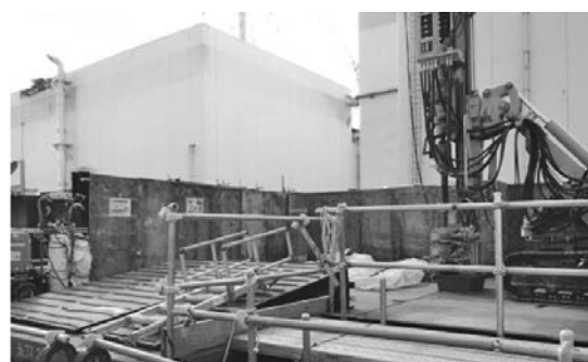
写真-3 遮へいの例(重機置き場周りの鉛フェンス)
