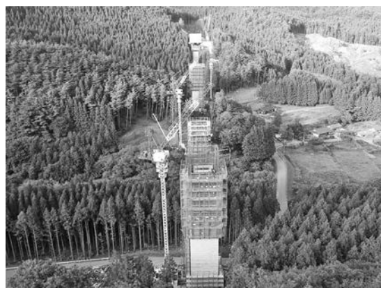
写真-3 本足場システム
