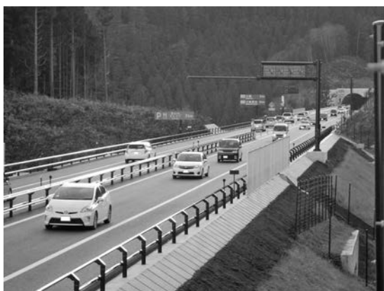
写真—8 吉浜道路の供用状況
