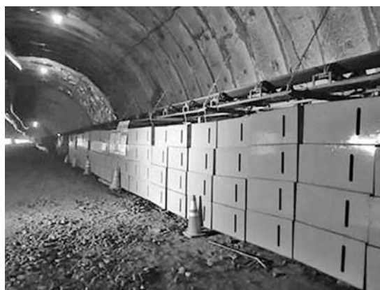
写真二 2 本吸音システム設置状況
