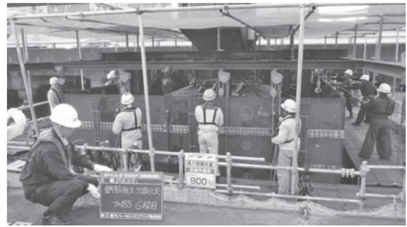
写真一 鋼殻沈設状況
