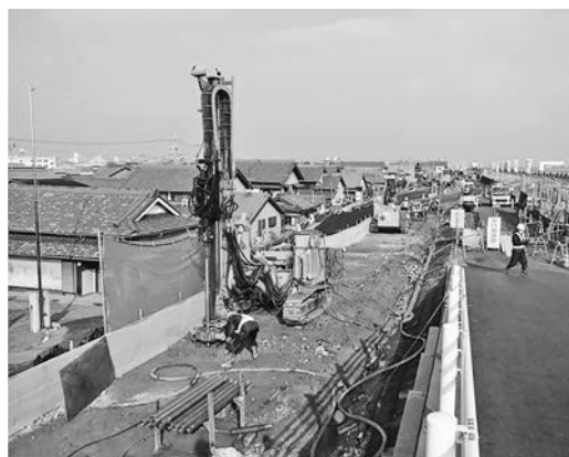
写真—2 本工法の施工状況
