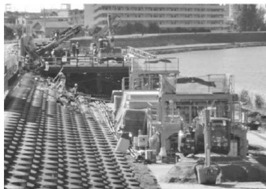
(b) 傾斜施工による施工状況写真
