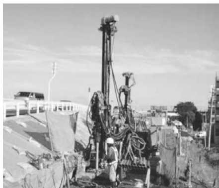
(a) 狭隘地における施工
