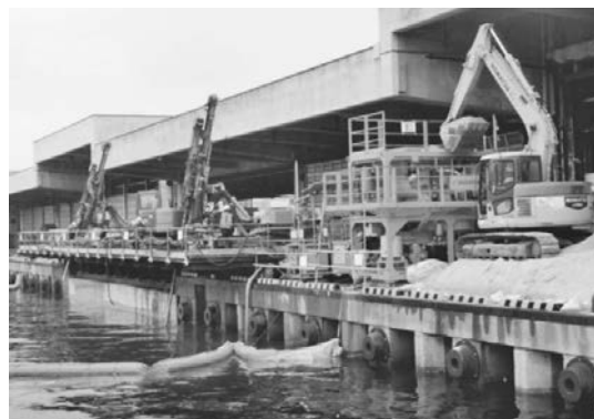
(b) 施工状況写真
