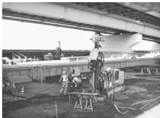
(b) 空頭制限下における施工
