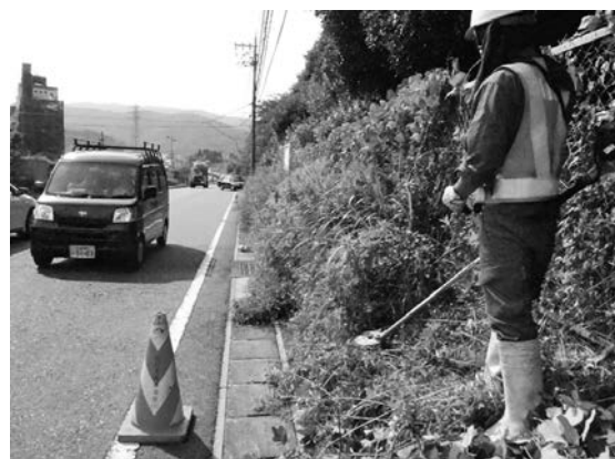
写真三 国道除草
