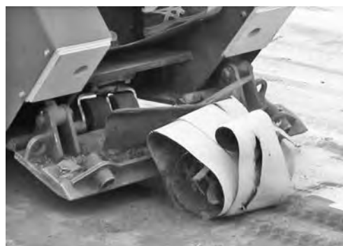
写真二 新工法の施工現場② (剥離作業中)
