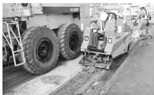
写真一 新工法の施工現場①
