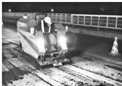
写真三 新工法の夜間施工
