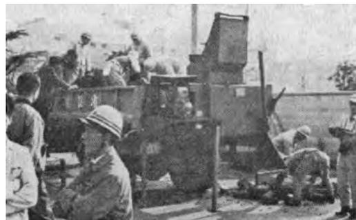
写真 3-23 富士物産製 HM-1A 型 ヒータ・ミックス (廃材再生用)
