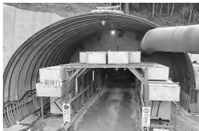
写真—1 TBI レゾネータ Type-F の設置状況（面積比 5%）
