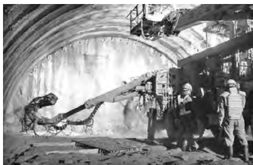
写真—1 トンネルナビ実施状況
