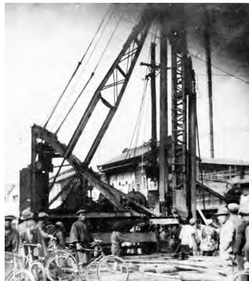
写真—1 ドイツ製の直立式杭打ち機
