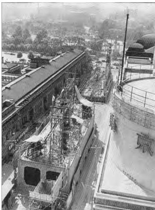
写真—8 内幸町付近の潜函工事
