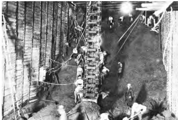
写真—4 万世橋までの建設に使用したエンドレスバケット
