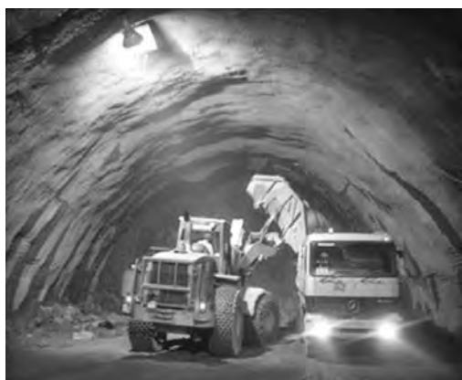
写真—1 貯槽アーチ部の掘削状況
