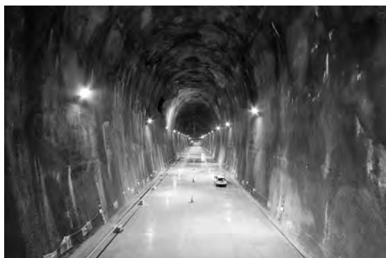
写真—2 貯槽掘削完了後の状況（No.3 貯槽）
