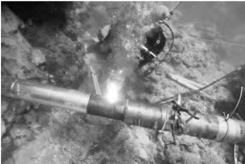
写真—14 先端編成切断状況
