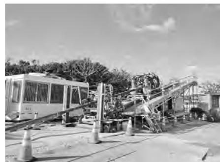
写真-2 水平掘削機設置状況
