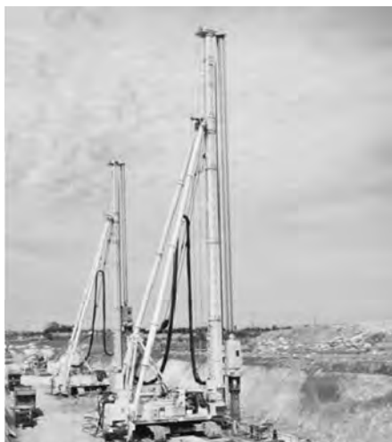
写真—1 施工状況
