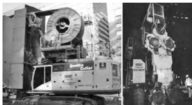
写真—2 掘削機械
