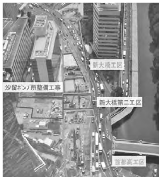
写真-1 工事箇所全景
