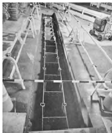
写真—3 建込み完了
