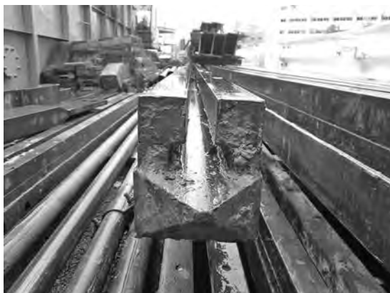
写真一八 防護パイプ (T型用)
