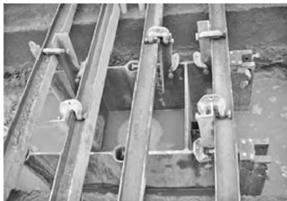
写真一〇 鋼製連壁部固定状況
