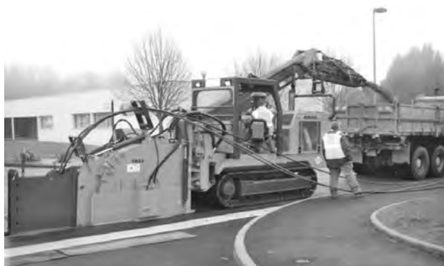
写真一 トレンチャーによるケーブル埋設状況の一例 (ホームページより引用 2) )
