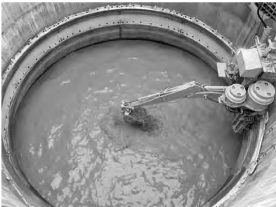
写真—2 ケーソン刃先付近での掘削・放土状況
