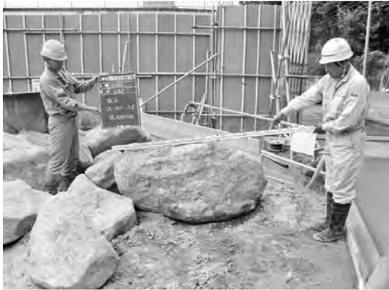
写真一5 ケーソン刃先下の1.6mの転石除去例
