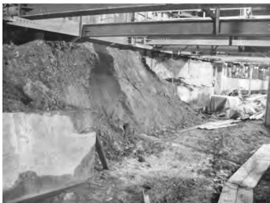
写真-6 小段掘削状況
