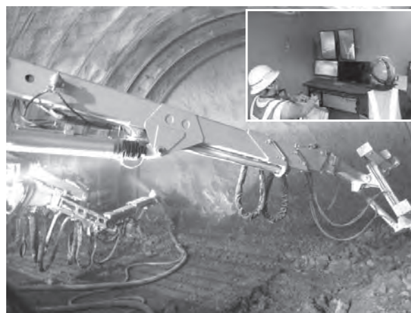
写真-2 遠隔操作による吹付け状況
