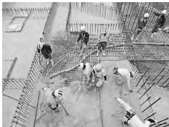
写真-5 耐圧盤打設状況
