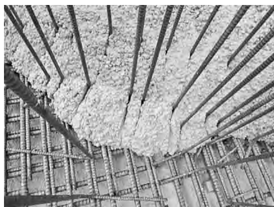
写真-6 本コンクリートの流動状況
