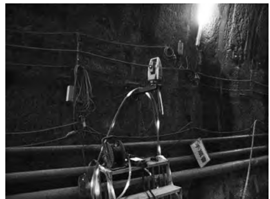
写真—8 掘削部を示す TS
