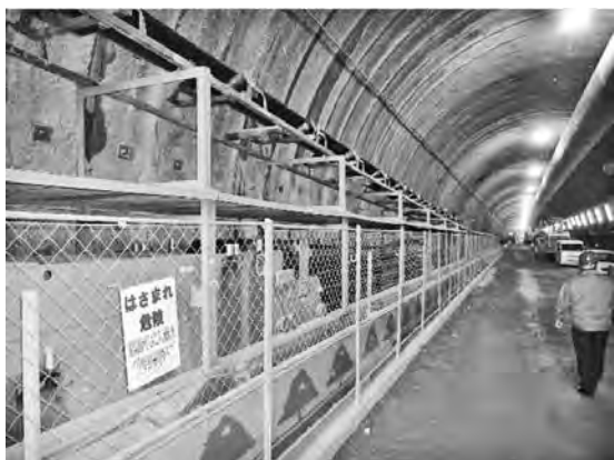
写真—9 移設したベルトコンベア
