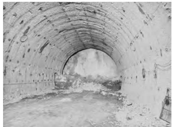
写真—7 下り線東側本坑切羽
