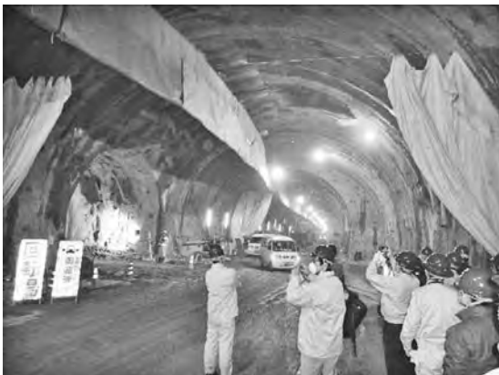
写真—4 現場見学状況
