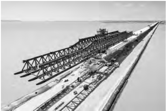
写真ー4 2列のトラス構造の架設桁
