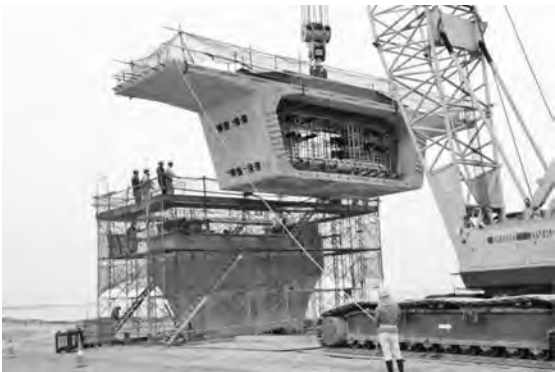
写真ー3 ハーフプレキャストセグメントの設置
