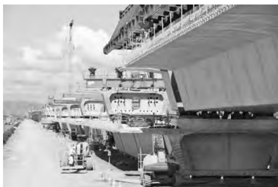
写真一七 径間セグメントの先行設置
