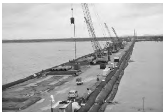
写真－1 ジオチューブによるアクセス道路
