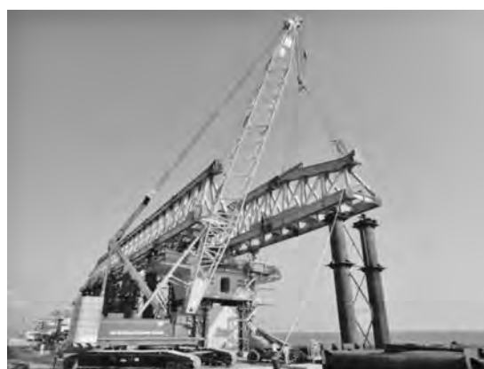
写真一13 架設桁組立
