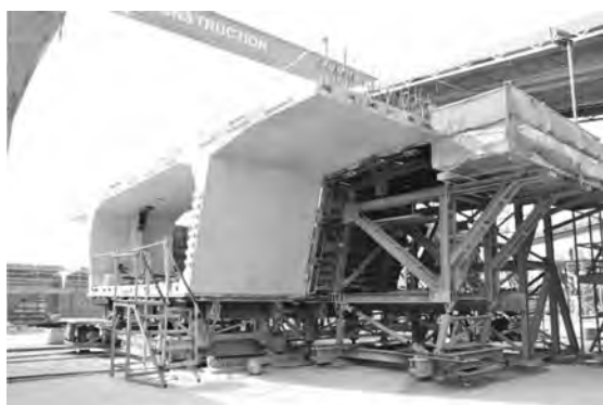
写真－2 ショートラインマッチキャスト方式によるセグメント製作
