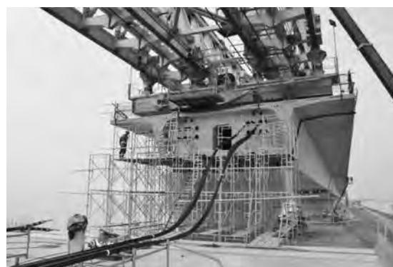
写真一九 前方より挿入される外ケーブル
