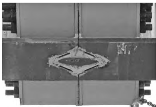
写真一六 架設桁接合部底面のひし形プレート
