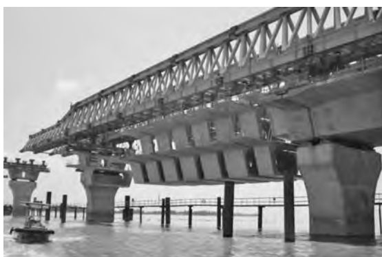
写真一八 海上部でのセグメントの吊上げ
