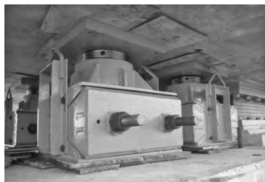
写真一12 600tくさび式ジャッキ
