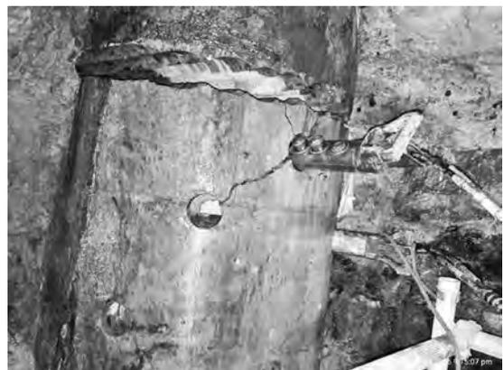
写真一 5 杭切断および静的破砕機使用状況
