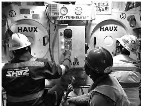
写真—4 圧気作業状況（マンロック外から撮影）
