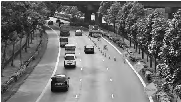
写真—5 高速道路における車線規制状況
