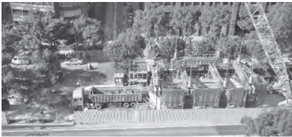
写真一1 第2立坑施工状況
