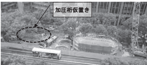
写真一2 加圧桁仮置き状況
