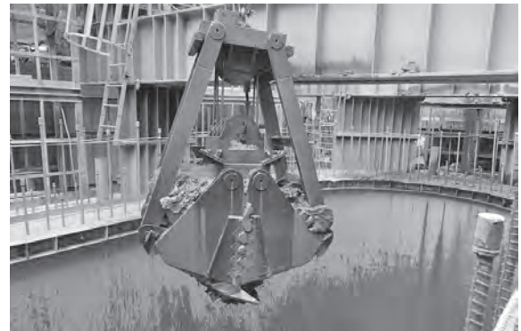
写真一3 クラムシェル型0.8m³級バケット
