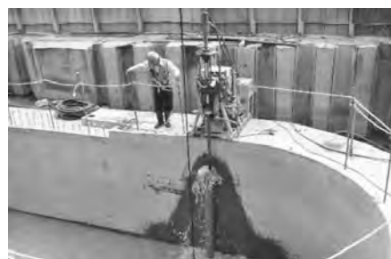
写真一6 高圧水による刃口洗浄
