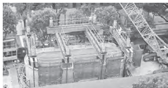
写真一4 ケーソン圧入設備全景
