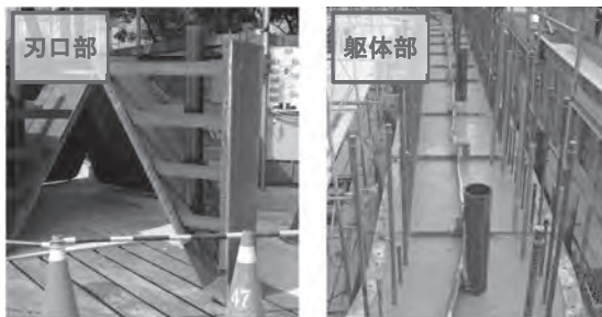
写真一5 ケーソン躯体壁6インチ鋼管埋設
